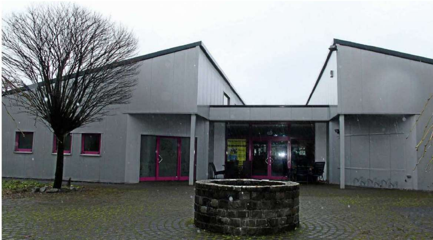
In diesem ehemaligen Fitnessstudio in Olsberg soll eine Kita entstehen. Das Problem: Erhebliche Feuchtigkeitsschäden.
